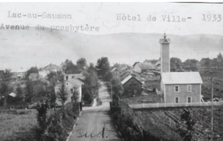
L'Avenue du presbytère, aujourd'hui la rue Bouillon, Lac-au-Saumon, 1933. Remarquez le changement de largeur de la rue à partir de l'hôtel de ville.
